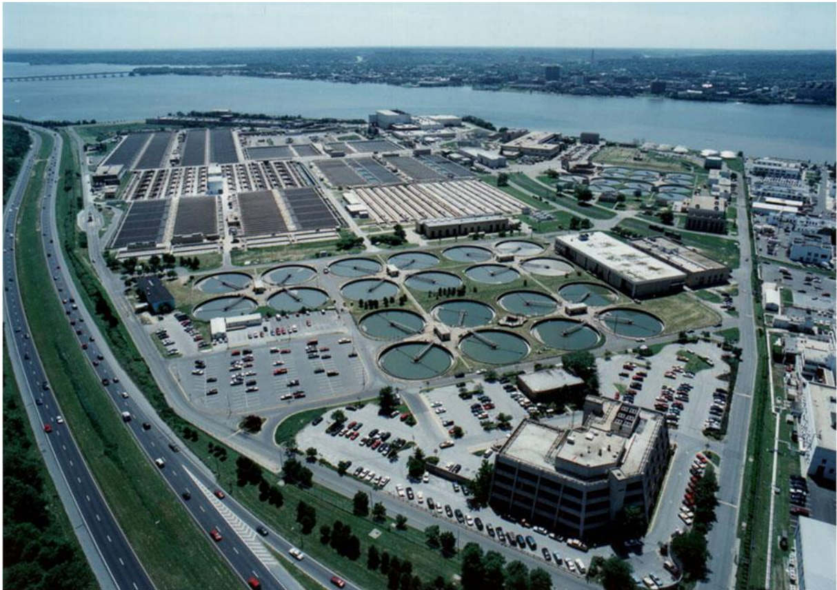
Ryc. 6. Blue Plains Advanced Wastewater Treatment Plant – największa oczyszczalnia ścieków na świecie [5]
