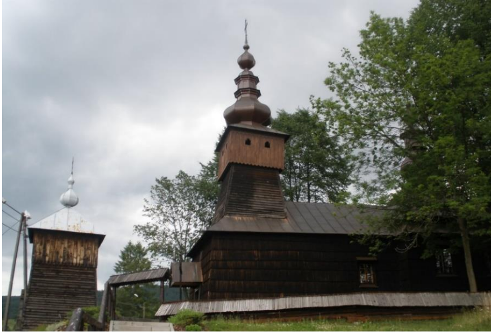
Ryc. 3. Cerkiew pw. św. Łukasza Ewangelisty w Jastrzębiku, przynależna do „Szlaku Architektury Drewnianej w Małopolsce”
