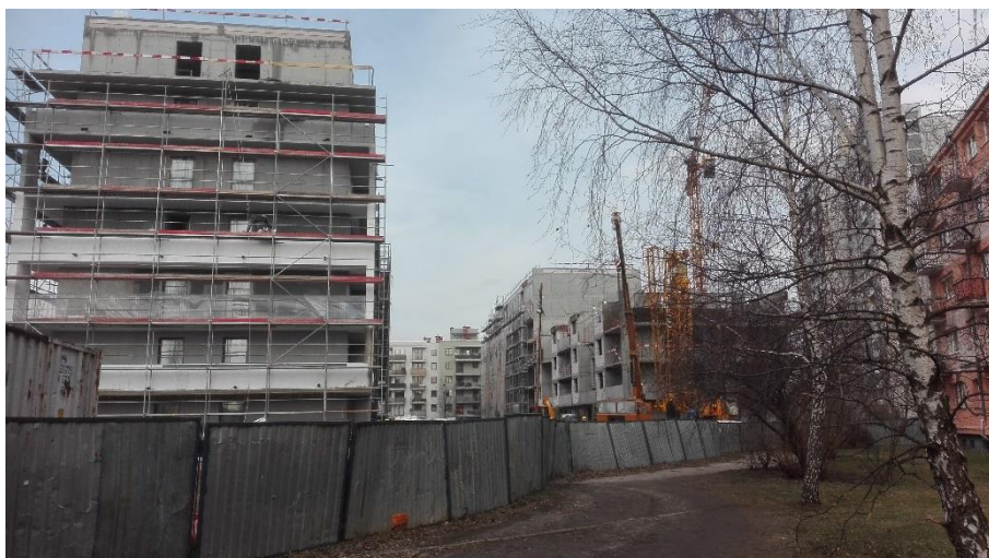
Ryc. 13. Budowa nowych bloków mieszkalnych w Gdańsku Przymorzu
