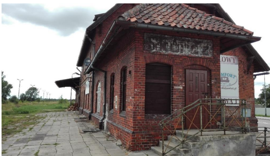
Ryc. 15. Nieczynny dworzec kolejowy w Skórczu
