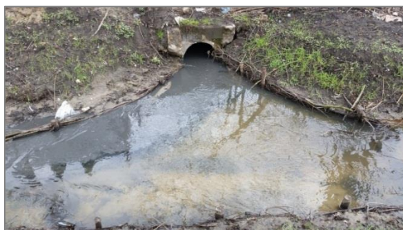
Ryc. 4. Niekontrolowany zrzut ścieków do Reguły
