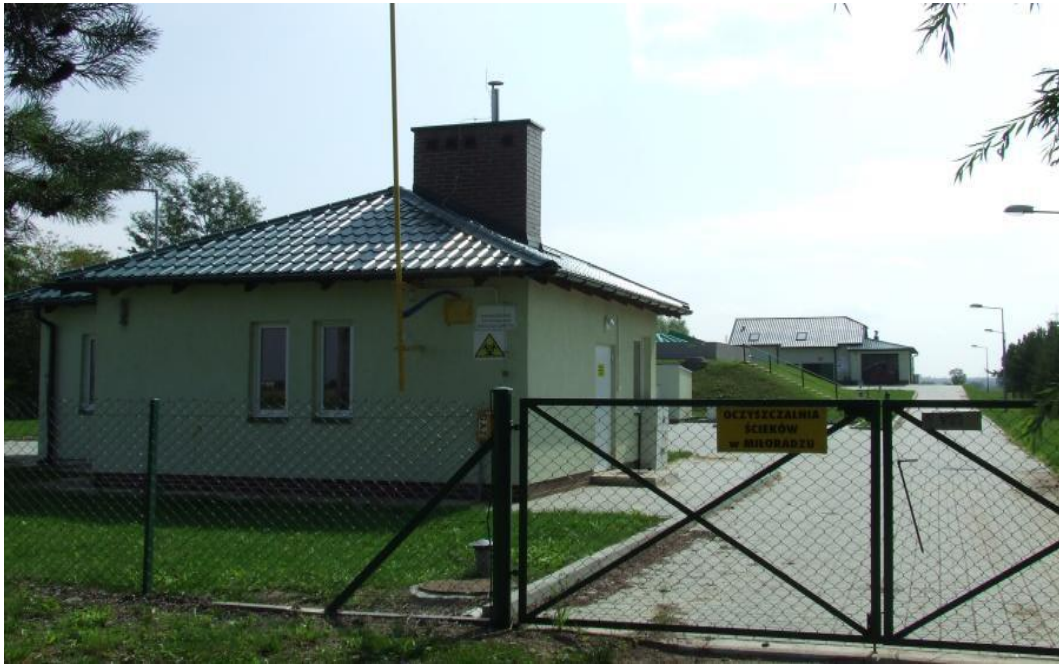
Ryc. 9. Oczyszczalnia ścieków w Miłoradzu
