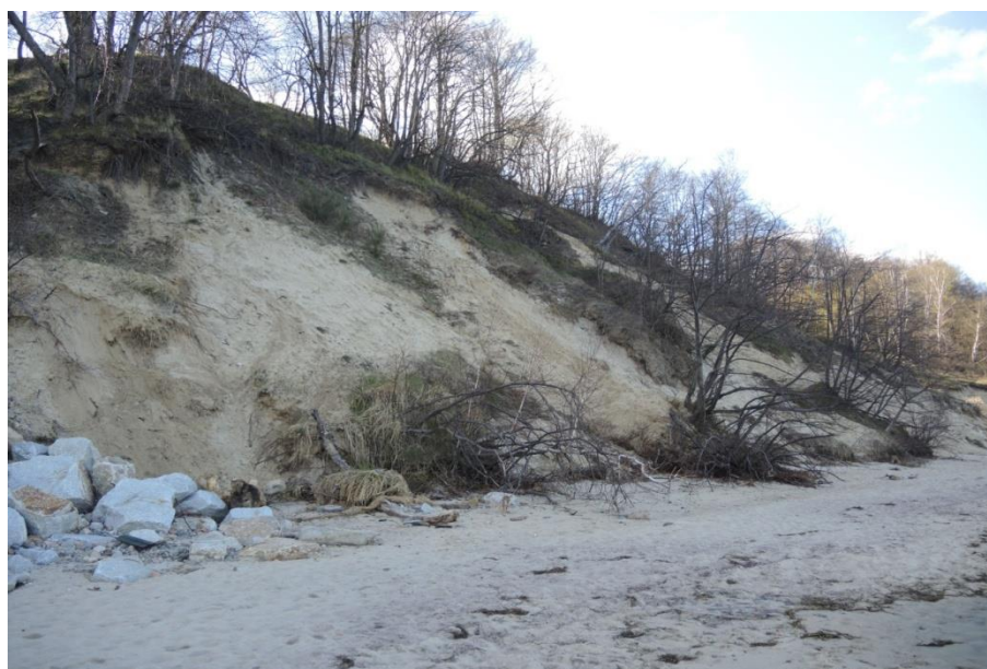
Ryc. 11. Osuwiska z konarami drzew z korony klifu
