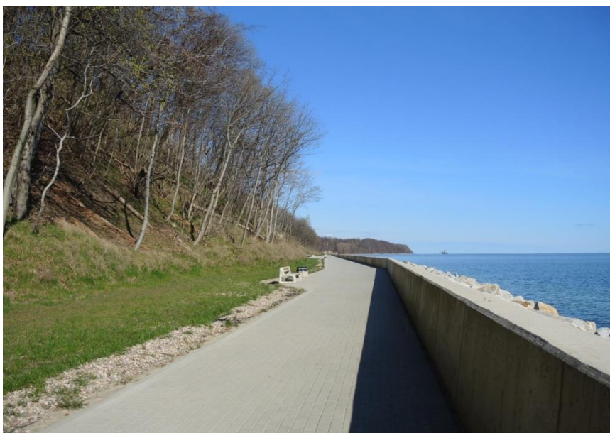
Ryc. 5. Pas techniczny zabezpieczający południową część klifu, w oddali widok na centralną część klifu w Babich Dołach
